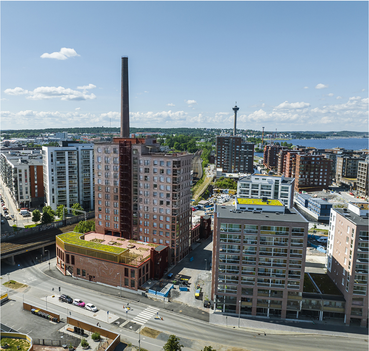
Kiinteistö Oy Tampereen Koelaitoksenkatu 22
