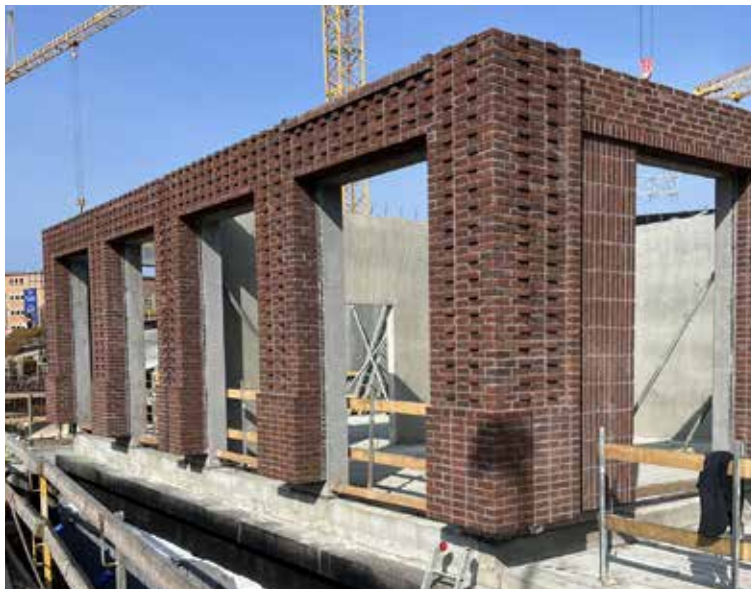
Facade fra Mejlbryggen B.
