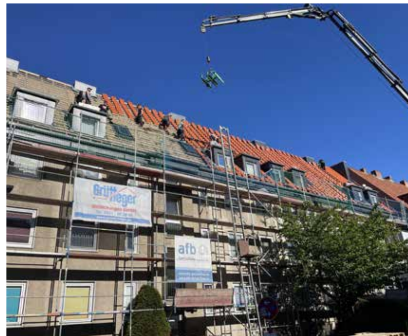
Detalje: Ny isolering og tagkonstruktion under udførelse
