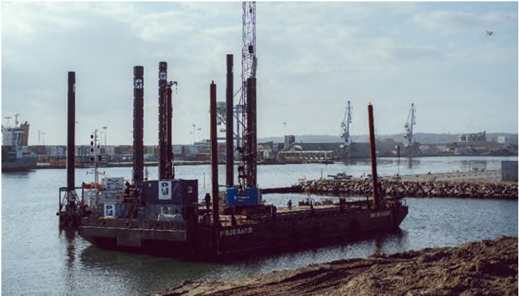
Omniterminalen i Aarhus Havn bliver forlænget med 430 meter ny kaj, og uddybet til en vanddybde på 14 meter.
