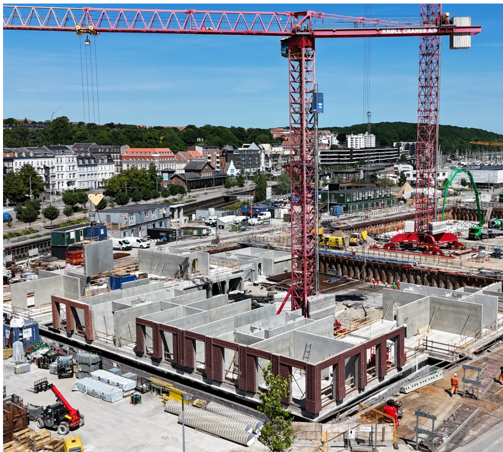
Byggeri følger tidsplan og alle byggekraner er på plads.
