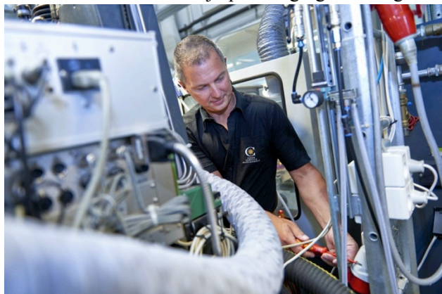
Den store facility management-virksomhed Coor skal fra 1. januar 2018 stå for ejendomsdriften i Københavns Kommunes knap 300
